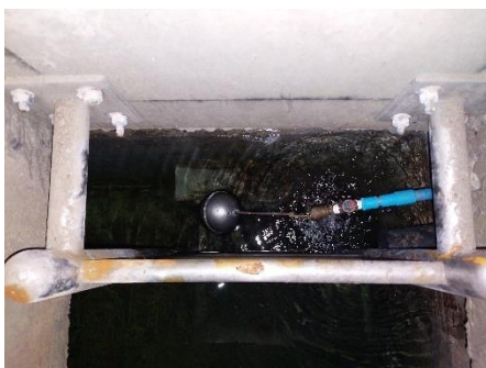
ภาพที่ 2.2-6 ถังเก็บน้ำสำรอง (ถังเก็บน้ำใต้ดินและถังเก็บน้ำสำรองชั้นดาดฟ้า)
